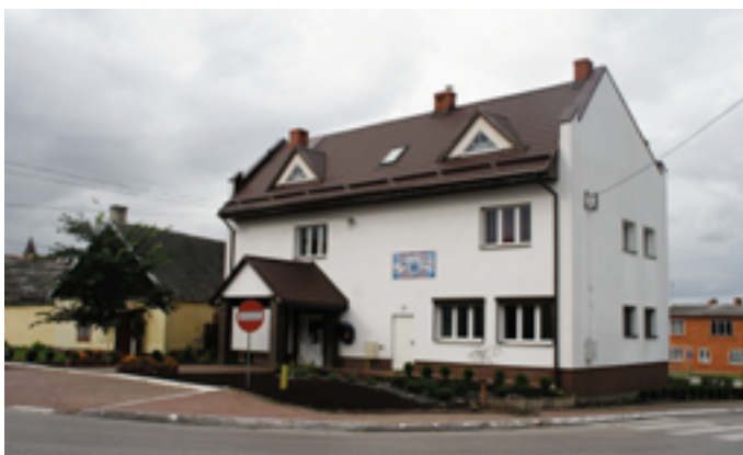
Centrum Kultury i Aktywności Lokalnej w Gowarczowie
