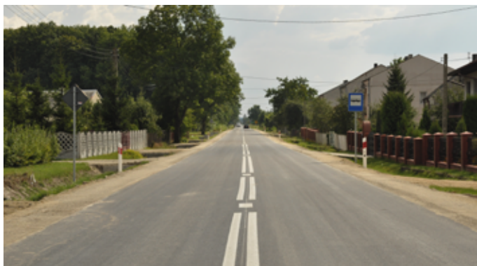
Nowa droga Błogoszów-Przygradów
