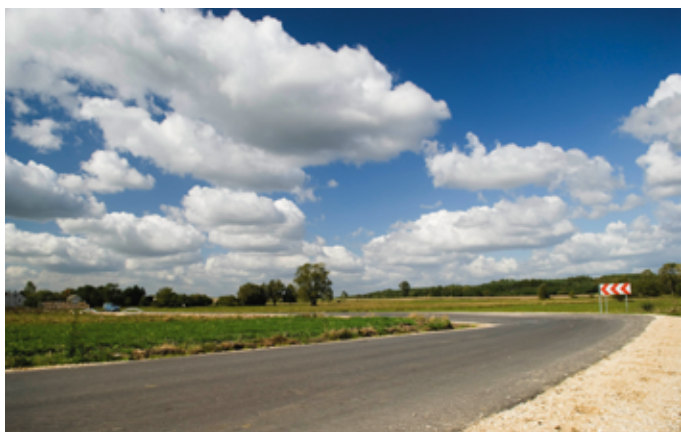
Przebudowana droga w Gminie Tuczępy w miejscowości Chałupki
