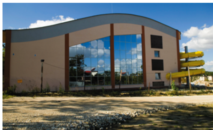
Rozbudowany kompleks sportowo-rehabilitacyjno-edukacyjny w Sędziszowie to doskonały przykład zmian, jakie zachodzą w regionie dzięki RPO.
