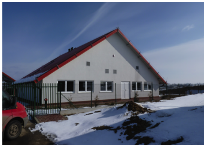
Oczyszczalnia ścieków w Tarczku
