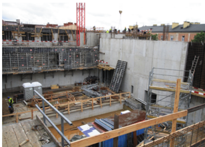
Budowa Międzynarodowego Centrum Kultury przebiega zgodnie z planem
