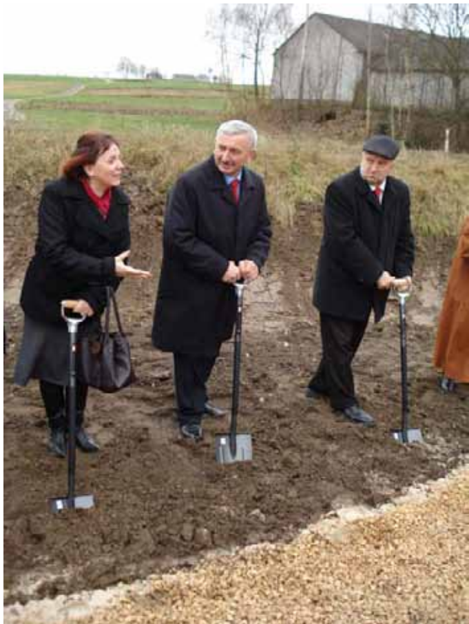
Symboliczne wbicie pierwszych łopat, inaugurujące budowę obwodnicy Nowej Słupii.
