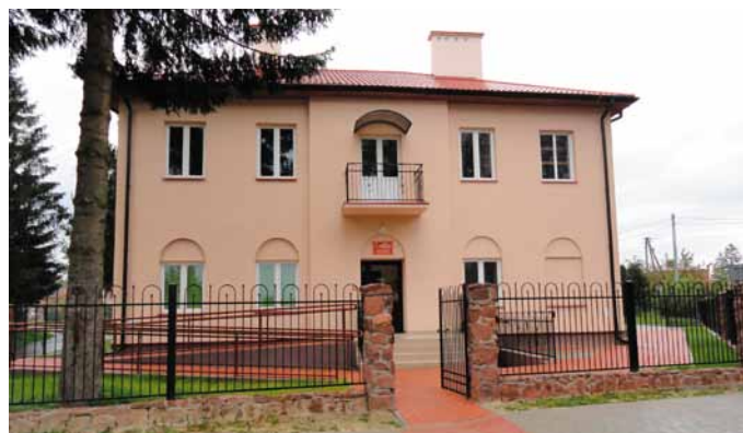
Wiejski Dom Kultury w Starym Garbowie
