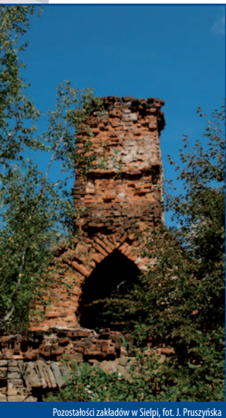
Pozostałości zakładów w Sielpi, fot. J. Pruszyńska
