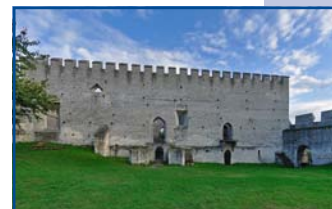
Mury obronne Szydłowa, fot. arch. PolskaTurystyczna.pl
