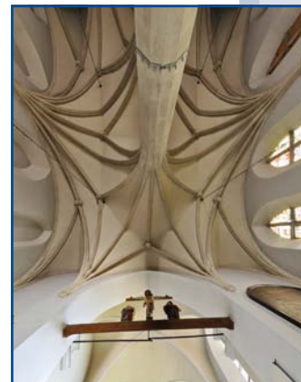
Sklepienie palmowe – kościół św. Władysława w Szydłowie, fot. arch. PolskaTurystyczna.pl
