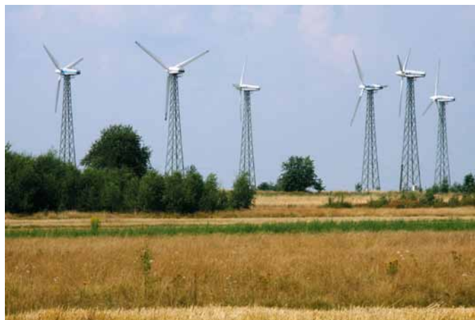
W naszym województwie działa 10 farm wiatrowych sprzedających energię elektryczną do sieci energetycznych
