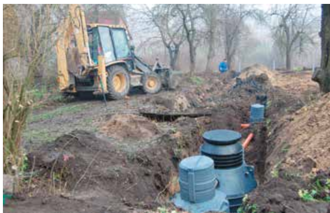
W gminie Złota zainstalowano 336 przydomowych oczyszczalni
