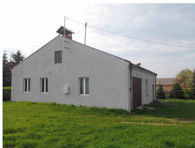
W budynku remizy po remoncie mieścić się będzie świetlica wiejska
