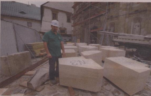
- Te kłocki ważą do 1,5 tony - mówi kierujący budową Paweł Krzysiek.
