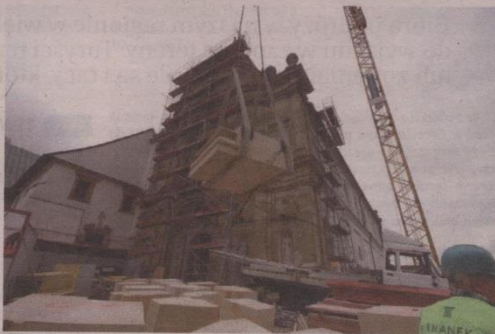
Przy pomocy dźwigu na górę wciągane są kamienne elementy, z których składana jest wieża.
