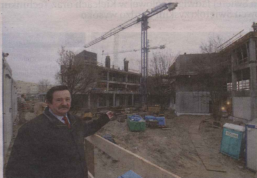
Dyrektor Jan Gierada mówi, że nowy Szpital Dziecięcy będzie gotowy na koniec listopada. Jest już trzecia kondygnacja.
