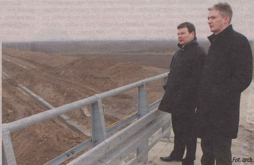
Radny TOMASZ RAMUS i marszałek ADAM JARUBAS wizytowali prace remontowe na wale Koprzywianki.
