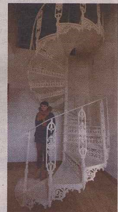
Żeliwna klatka schodowa.
