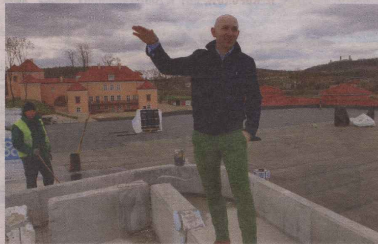
Dach budynku zostanie przykryty ziemią, będzie na nim rosła trawa - wyjaśnia Marcin Perz.
