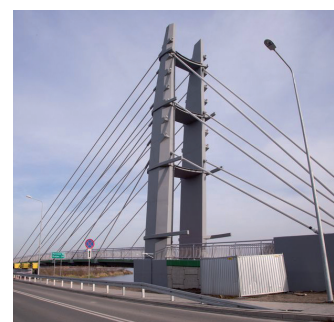
Przebudowana droga wojewódzka nr 728
