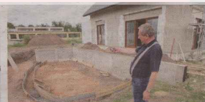
Przed domem właśnie budowany jest staw. - Promienie słoneczne będą odbijać się od wody i wpadać do domu przez okna – wyjaśnia kierownik budowy Józef Jarek z firmy Agat. Dodaje, że w wodzie będzie rosta trzcina filtrująca wodę.
