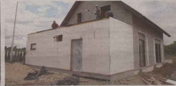
Dom samowystarczalny ogrzewany będzie za pomocą specjalnych sond ciepła zamontowanych pod budynkiem. - Będzie to swego rodzaju ogrzewanie podłogowe - tłumaczy Józef Jarek.
