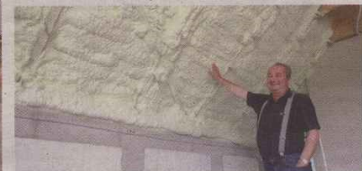
Wewnętrzna strona dachu pokryta jest pianką poliuretanową, która ma go uszczelnić i nie dopuścić do utraty ciepła.
