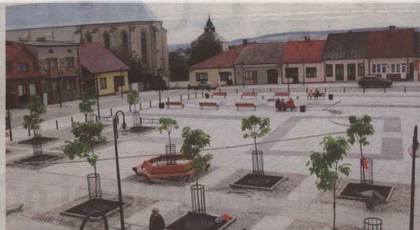
Rynek w Bodzentynie przeszedł gruntowny remont.
