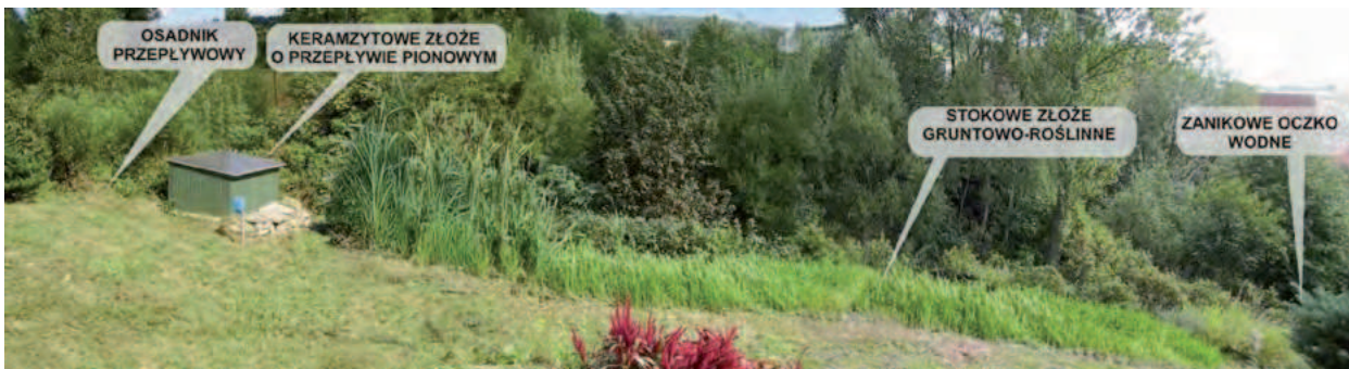
Fot. 6. Widok ogólny oczyszczalni w gospodarstwie domowym zamieszkałym przez 7 osób
