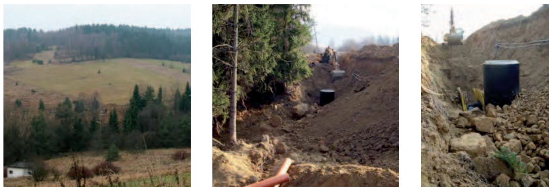
Fot. 3, 4, 5. Przykład budowy kolektora zbiorczego w terenie górzystym
