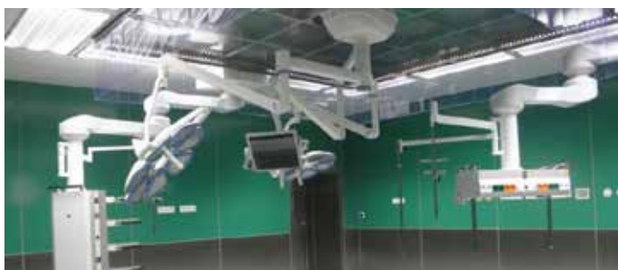
Rozbudowa Szpitala w Staszowie poprzez budowę bloku operacyjnego
