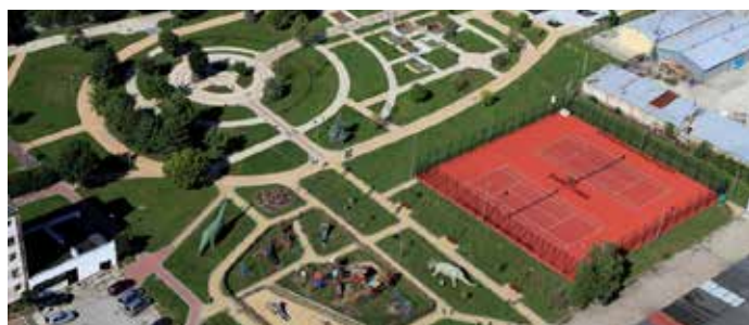
Budowa infrastruktury służącej rozwojowi aktywnych form wypoczynku na terenie Miasta i Gminy Połaniec
