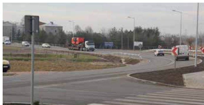
Wielebnow w gm. Łopuszno. Przebudowaną w dwóch etapach drogą 786 można komfortowo jechać w stronę Śląska od Kielc do granic województwa świętokrzyskiego
