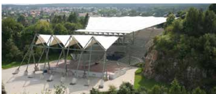
Geopark Kielce - przebudowa Amfiteatru Kadzielnia
