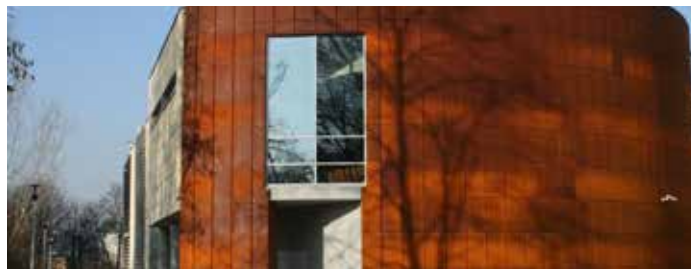
Budowa Uniwersyteckiego Centrum Edukacji Artystycznej jako części Wydziału Pedagogicznego i Artystycznego przy ulicy Krakowskiej w Kielcach. Całkowita wartość projektu 10 275 383,60 zł.
