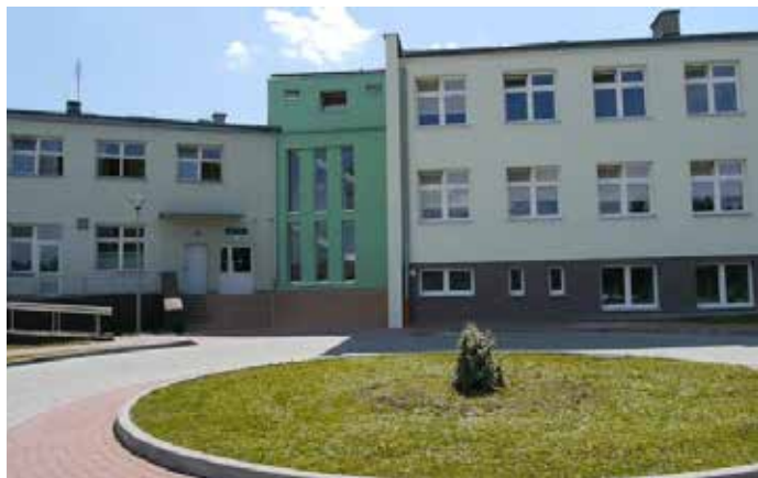
Rozbudowa, modernizacja i wyposażenie szpitalnych oddziałów Świętokrzyskiego Centrum Psychiatrii w Morawicy
