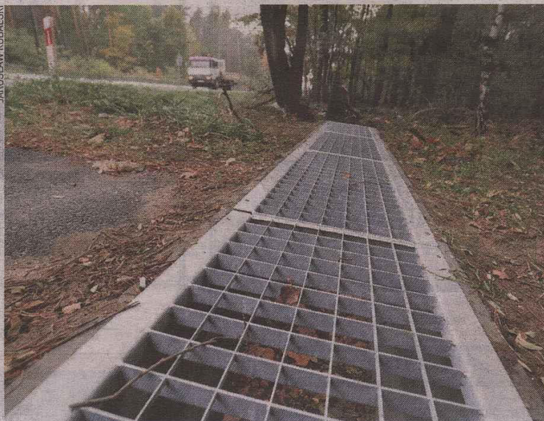
Stopryny montowane są już przy trasie 786 Kielce - Włoszczowa
