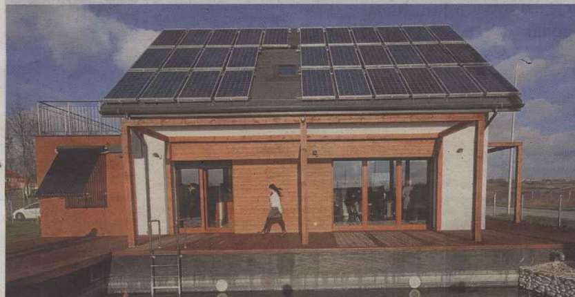
► Od południa dom doświetlony jest stawem, dach pokrywają solary. Wzdłuż budynku taras, drugi jest przy sypialni, nad garażem.
