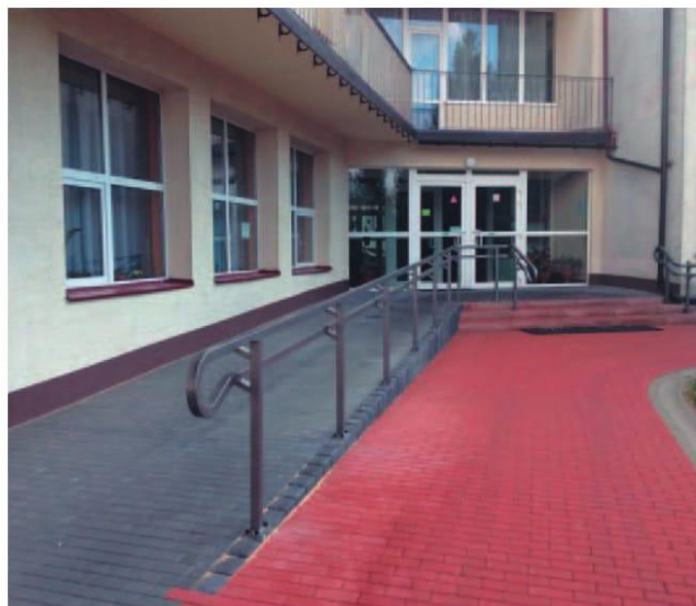
Podjazd dla niepełnosprawnych oraz ciągi komunikacyjne w Domu Pomocy Społecznej w Brodach prowadzonym przez Zakład Produkcyjno – Handlowy „ADAX”
