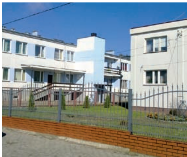
Ośrodek Zdrowia w Pierzchnicy: Szyb windy dobudowany do budynku, przystosowany do przewozu osób niepełnosprawnych
