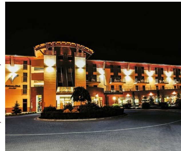
📷 Hotel „Malinowy Zdrój” w Solcu-Zdroju, fot. arch. ROTWŚ
