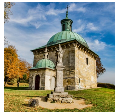
Kaplica św. Anny w Pińczowie, fot. arch. UMWŚ w Kielcach
