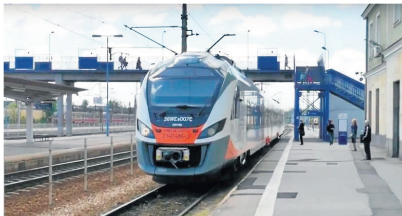
W Skarżysku powstanie przejście pod torami połączone ze zmodernizowanym budynkiem dworca. Przebudowane zostaną także perony nr 1 i nr 2.
