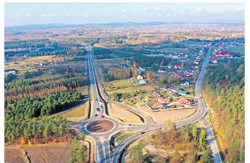
To najdłuższy odcinek drogowy realizowany w Programie Operacyjnym Polska Wschodnia, z dofinansowaniem, które jest jednym z najwyższych.
