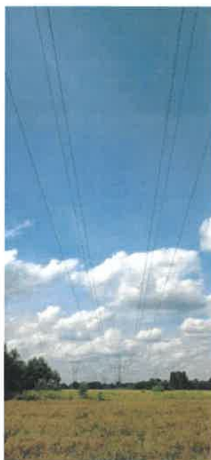
Widok na przęsło 32 – 33
