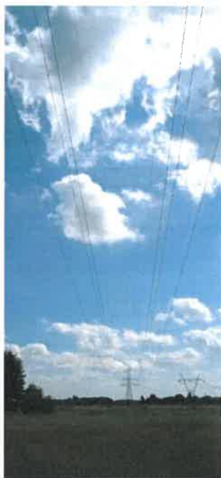
Widok na przęsło 31 – 32
