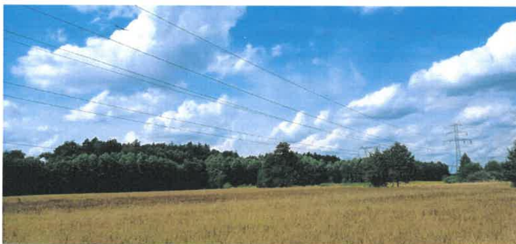
Widok na przęsło 29 – 30
