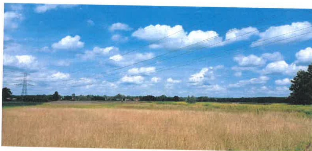
Widok na przęsło 30 – 31
