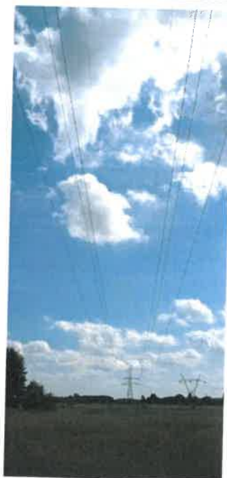
Widok na przęsło 31 – 32
