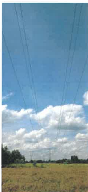
Widok na przęsło 32 – 33
