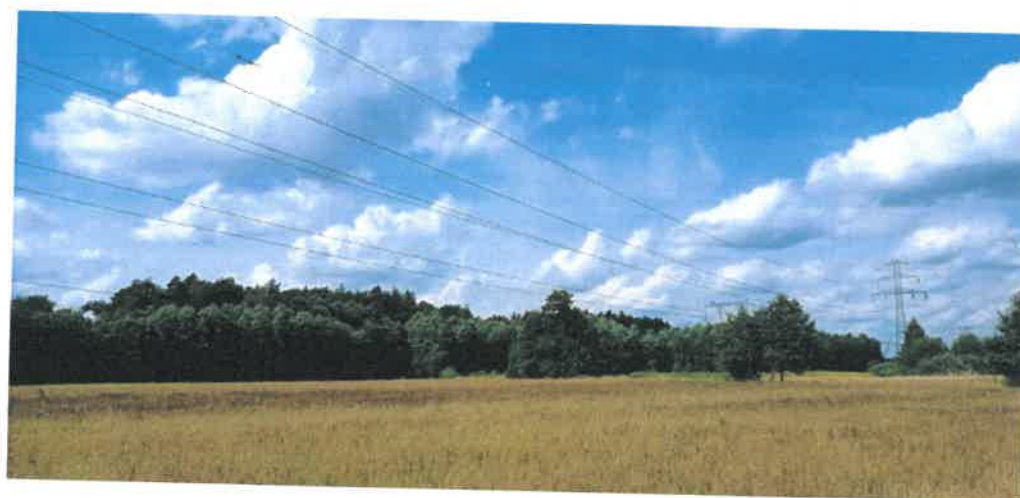
Widok na przęsło 29 – 30
