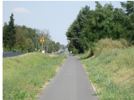
Rysunek 15. Droga dla rowerów ma lepszy profil podłużny niż jezdnia drogi wojewódzkiej
