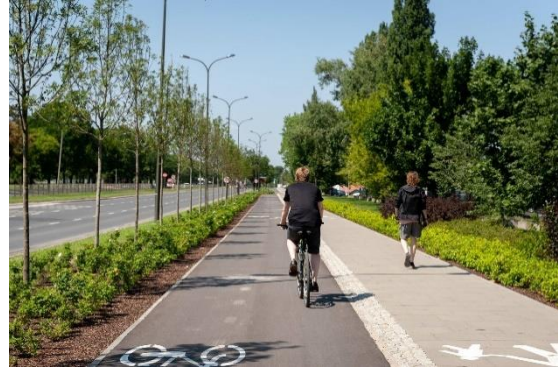
Rysunek 25. Warszawa. Prawidłowa nawierzchnia drogi dla rowerów oraz jej położenie względem chodnika, separacja od ruchu pieszego oraz zieleń (drzewa) zwiększająca atrakcyjność
