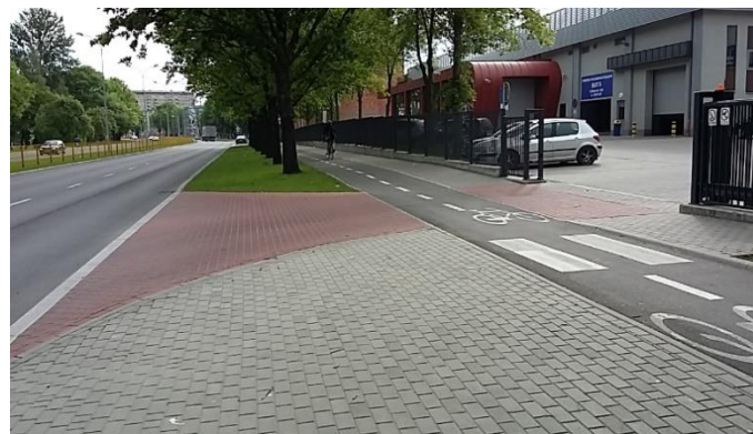
Rysunek 9. DDR z zachowaną nawierzchnią i niweletą w poprzek dojazdu do posesji
