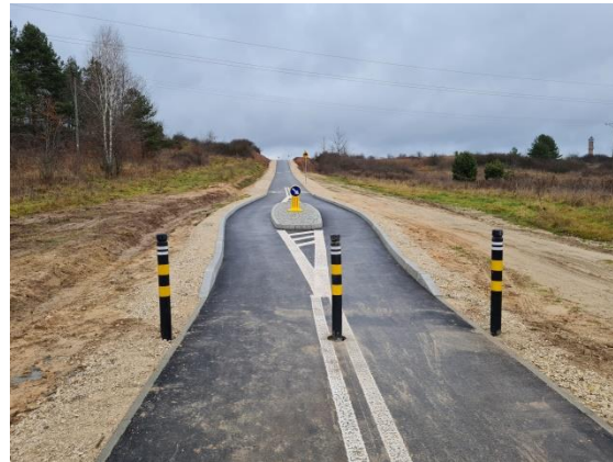
Rysunek 27. Kielce, Prawidłowa lokalizacja słupków umożliwiająca bezpieczne mijanie się dwóch rowerów
