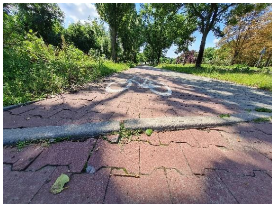
Rysunek 16. Wysoki krawężnik, Kielce
