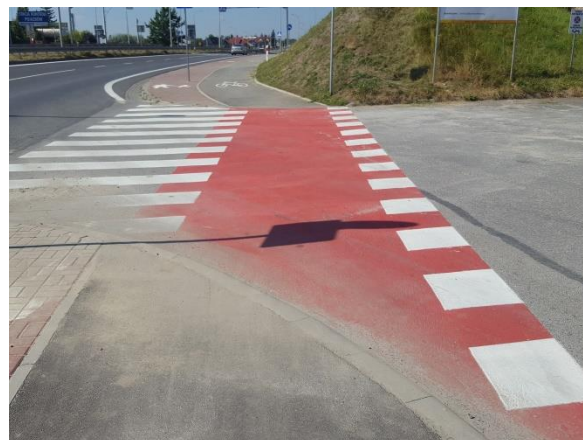
Rysunek 17. Zniekształcone krawężniki na przejeździe rowerowym, Nowiny
