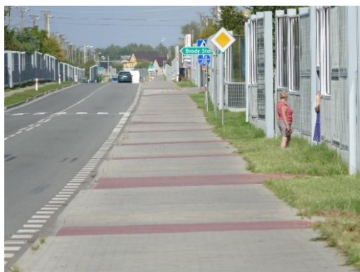
Rysunek 14. Sielcia - Końskie - brak zachowania niwelety na wyjazdach z posesji, tzw. „fale Dunaju”
