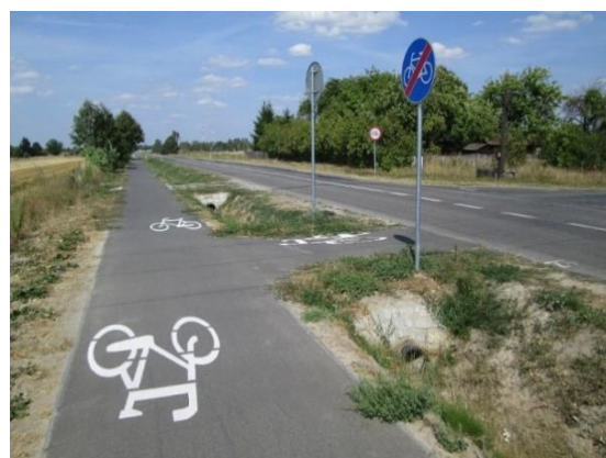
Rysunek 7. Prawidłowy sposób włączenia drogi dla rowerów w jezdnię jako czwarty wlot umożliwiający skomunikowanie z drogą poprzeczną
