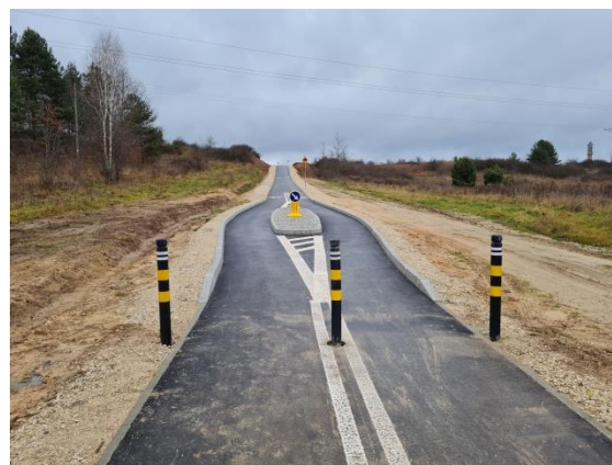
Rysunek 27. Kielce, Prawidłowa lokalizacja słupków umożliwiająca bezpieczne mijanie się dwóch rowerów
