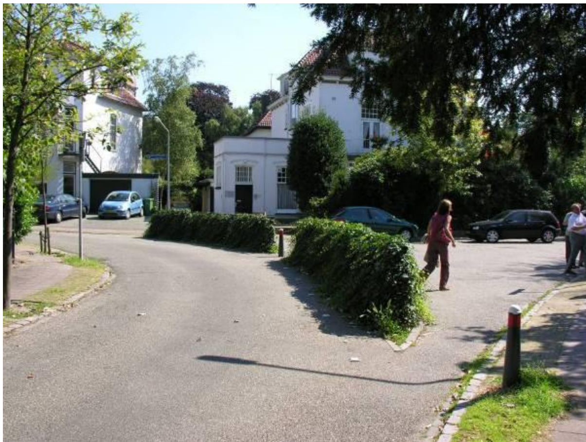
Ilustracja 33: Jedna z form rozcięcia skrzyżowania uniemożliwiającego przejazd samochodem a umożliwiającego przejazd rowerem.
