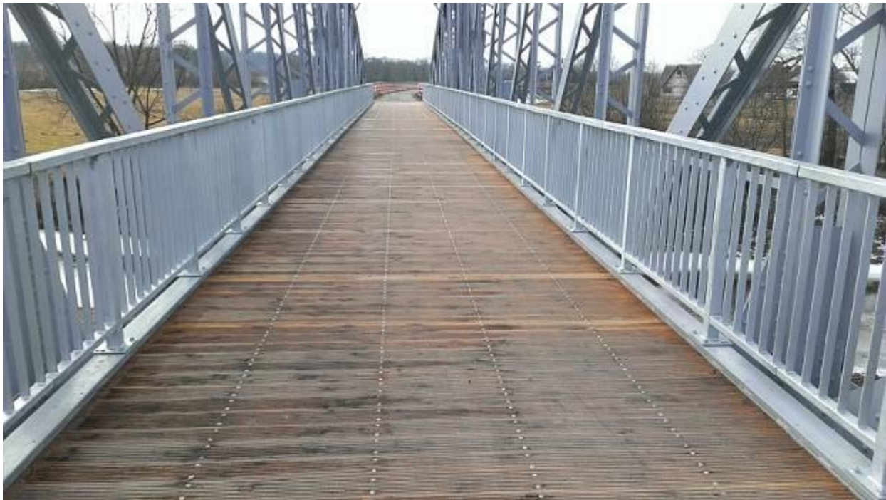
Ilustracja 20: Przykład adaptacji mostu kolejowego na kładkę rowerową (okolice Ludźmierza, powiat nowotarski).
