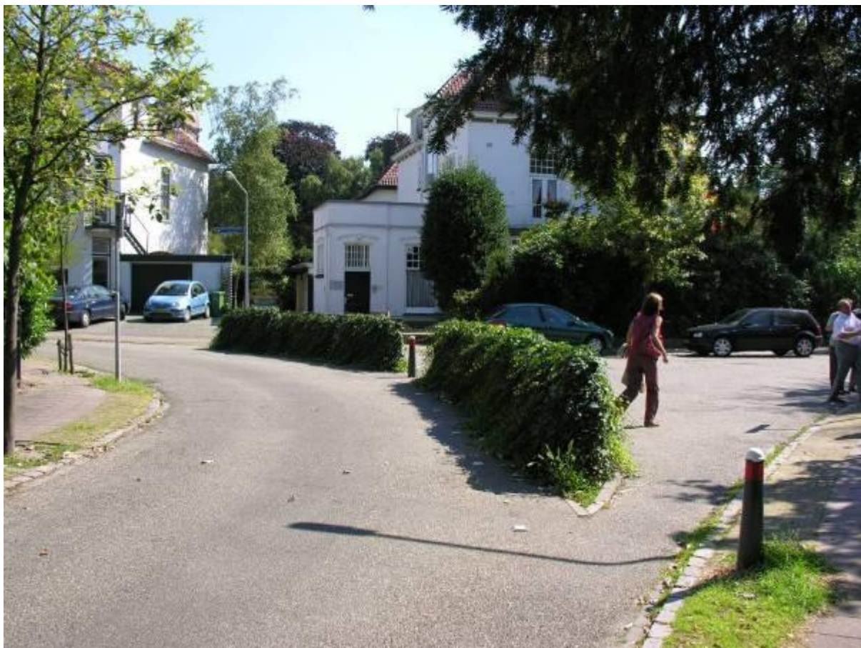
Ilustracja 257: Jedna z form rozcięcia skrzyżowania uniemożliwiającego przejazd samochodem a umożliwiającego przejazd rowerem.
