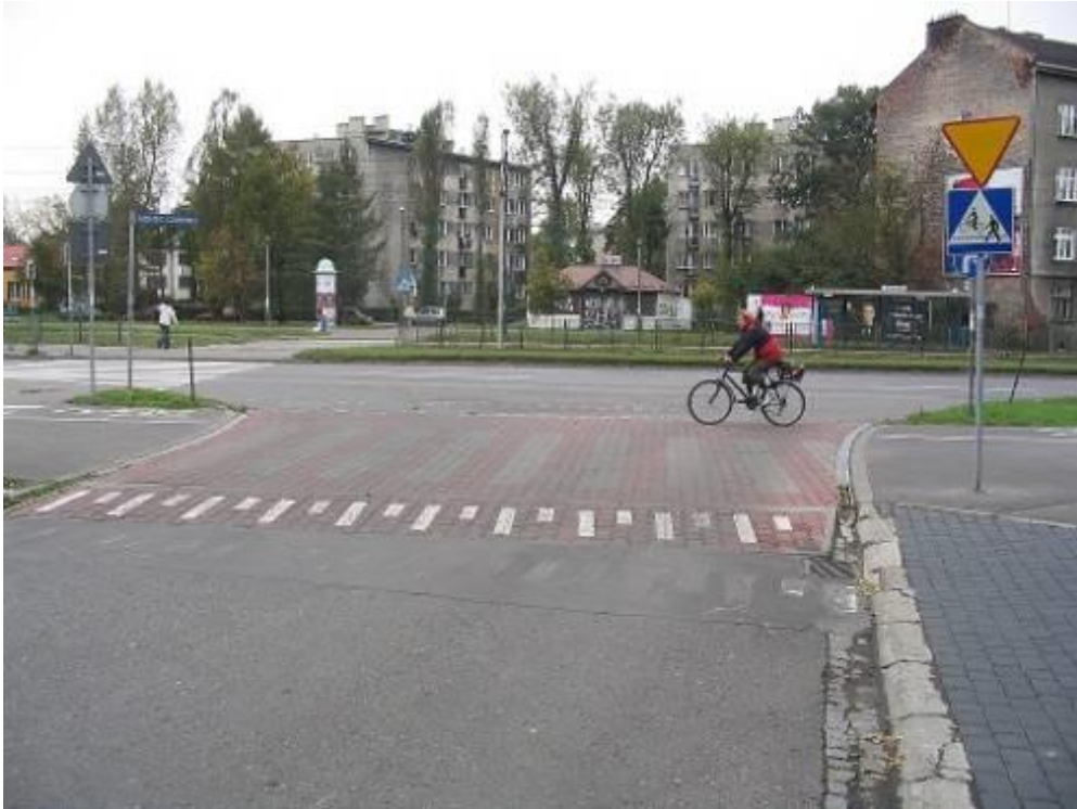
Ilustracja 8: Przejazd dla rowerzystów prowadzony grzbietem progu zwalniającego poprawia BRD
