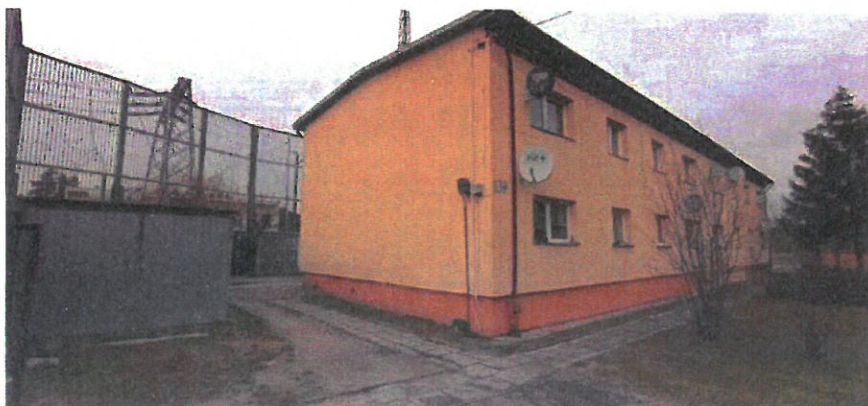
Stacja elektroenergetyczna 220/110 kV SE Radkowice. Budynek mieszkalny przy stacji
