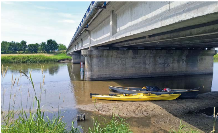
Most na drodze krajowej w Pińczowie
