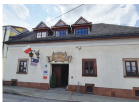
Punkt Informacji Turystycznej w Chęcinach, zabytkowa kamienica „Niemczówka”
