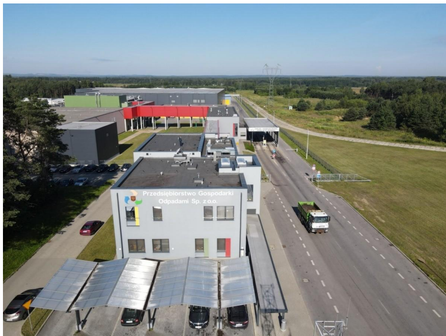
Fotografia 3. Regionalny Zakład Zagospodarowania Odpadów w Promniku, Przedsiębiorstwo Gospodarki Odpadami sp. z o.o. w Promniku ( https://pgo.kielce.pl/ )
