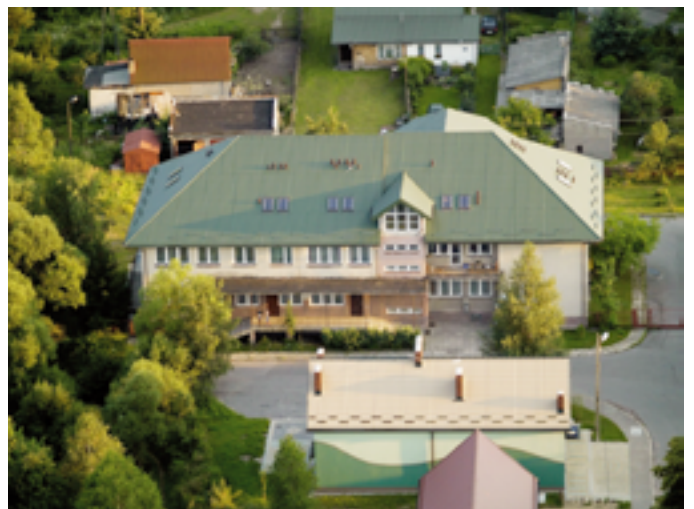
Ośrodek zdrowia zyskał nowy dach
