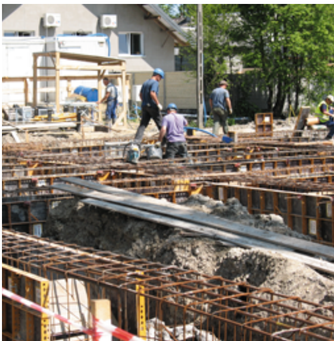
Prace na budowie bajkowego centrum
