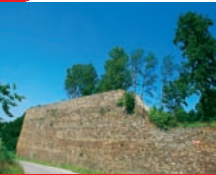
Mur oporowy w Bobrzy, fot. A. Drzewiecka
